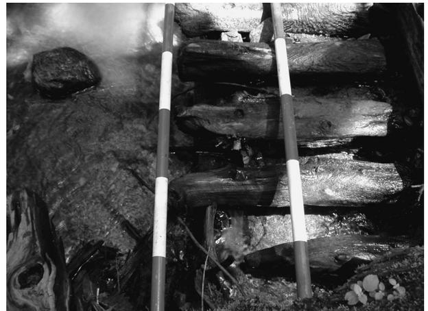
写真-6 λ型木製堰堤（1916年施工）の部材の摩耗の様子
