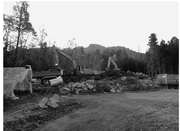
写真-2 二次被害の恐れがある不安定な堆積土砂を撤去する応急対策工の様子(平成31年1月、黒瀬地区)
