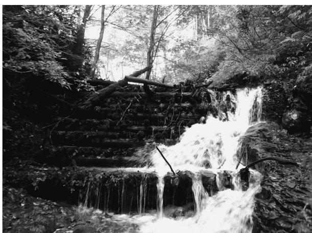
写真-2 λ型木製堰堤（1954年施工）の正面の様子
