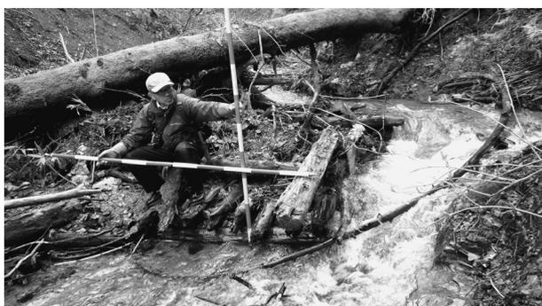
写真-7 1916年施工の木製堰堤の様子
