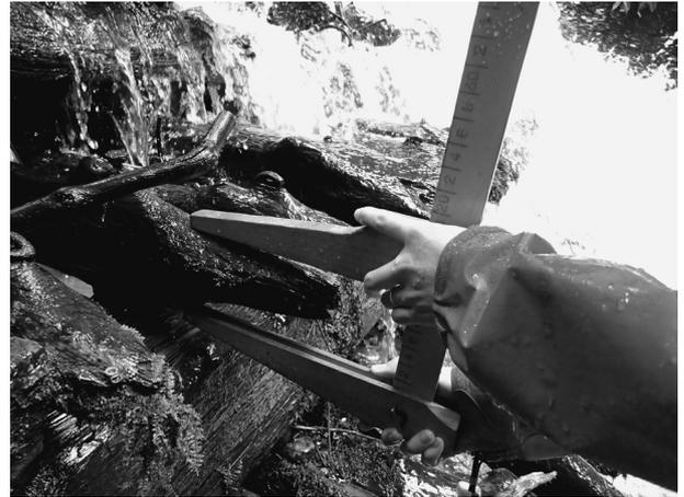
写真-5 λ型木製堰堤（1954年施工）の部材の摩耗の様子
