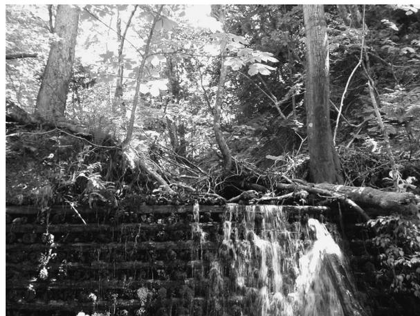
写真-3 台形型木製堰堤（1954年施工）の正面の様子
