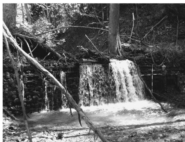
写真-4 台形型木製堰堤（1954年施工）の正面の様子
