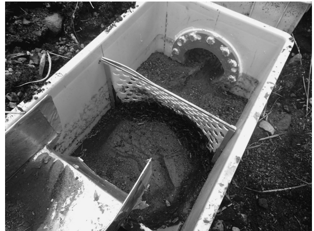
図-4 降雨中に路面から流出した大量の土砂
