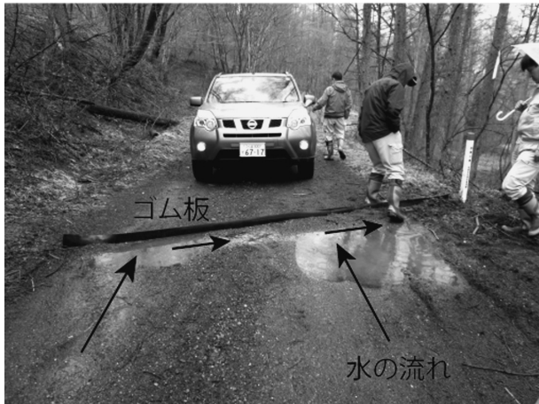
図-2 路面の排水に用いられるゴム板
