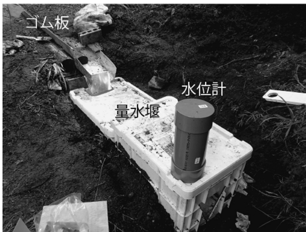
図-3 路面脇での量水堰設置の様子
