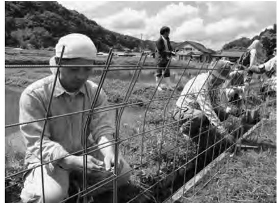
写真-1 イノシシの被害防止のためのワイヤーメッシュ柵の設置方法について学ぶ（野生鳥獣管理現地実習Ⅰ）。
