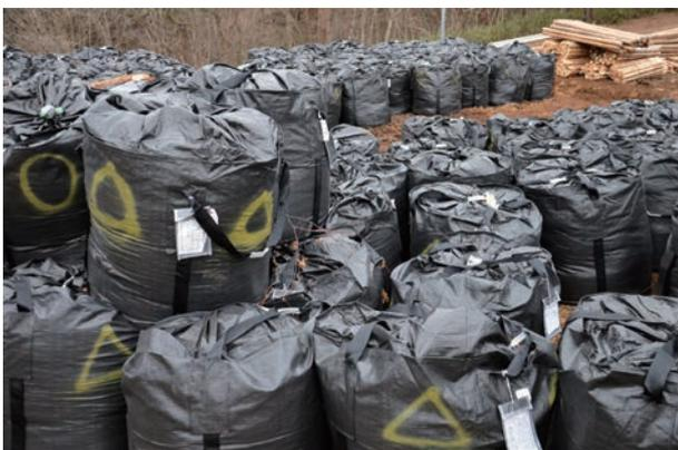
写真-2 除染実証事業で集められた除去物のフレコンバッグや木材の仮置き場(福島県飯館村)
