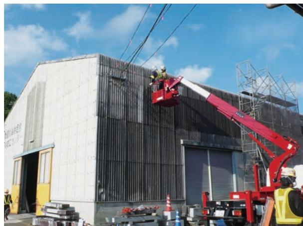
写真-2 飯舘村森林組合の石材加工センター建屋外壁の除染作業＝2013年8月22日、福島県相馬郡飯舘村、筆者撮影
