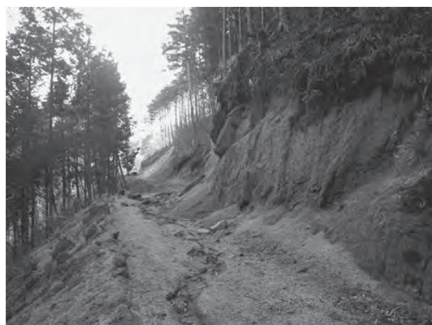
図-4 洗掘・切土崩壊の様子
