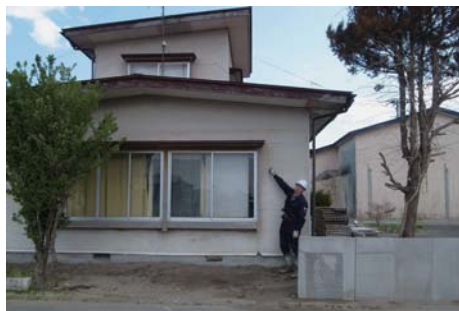
写真-6 建物等に残った津波痕跡
