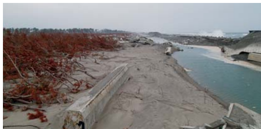
写真-1 破壊された防潮堤と背後の洗堀 防潮堤が破壊され海が見える。帯状の水面は越流した津波によって洗掘された凹地。林内には損壊した防潮堤の構成材料が入り込んだ。
