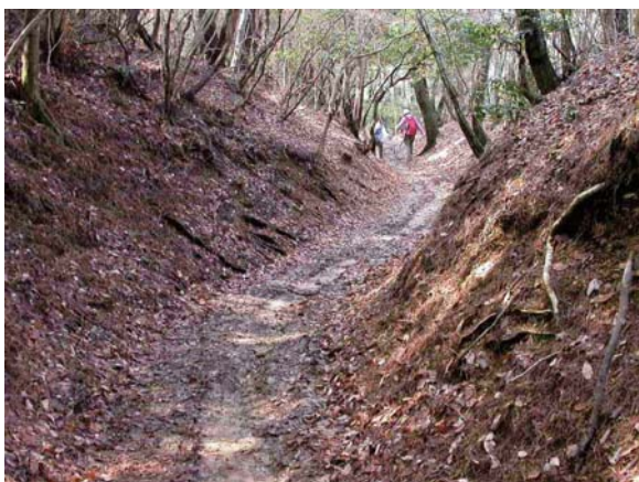
図-2 近代以前の整備された径路 近畿地方には、「ゆり道」と呼ばれる、伐り通しや築堤によって緩やかに整備された歩道が多く見られる。薪炭などの林産物搬出のための手押し車も通行した。何時ごろ、誰が整備したものであろうか。
