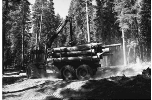
写真-3 フォワーダによる短幹集材作業
