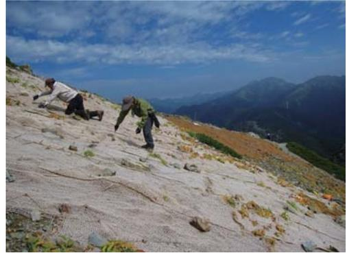
写真-6 土砂流出対策
