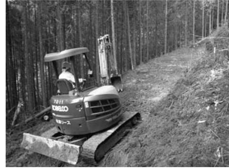
写真-6 宮演方式作業道の開設作業
