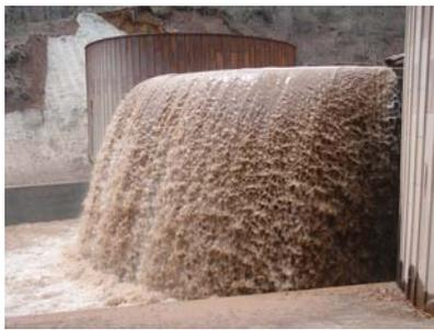
写真-4 融雪出水に伴って発生した土石流を捕捉した治山ダム（大きな石礫はダムで捕捉され、細かい土粒子を含む流水のみが流れているようす）（岩手県一関市産女川上流）
