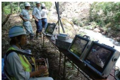
写真-3 無人化施工バックホウによる河道開削工事のようす(機械に取り付けたカメラ映像を見ながらリモコン操作)
