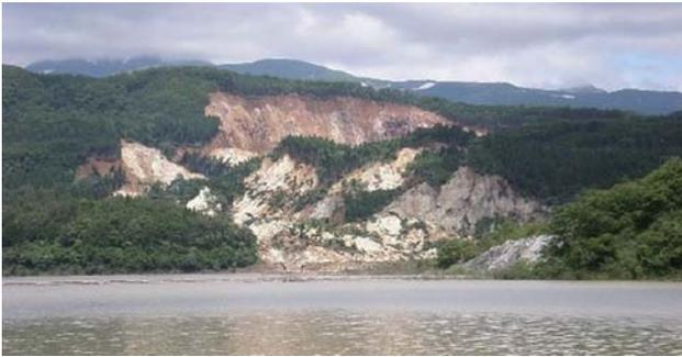
口絵-2 荒砥沢ダム貯水池から見た地すべり移動体土塊(背後に148mにも及ぶ滑落崖が見える)(第Ⅰ章参照)
