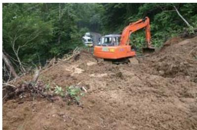
写真-2 林道上の崩土除去作業のようす(岩手県一関市祭時集落への迂回路)
