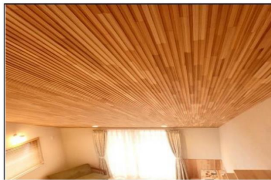
細長く製材したスギ（ラミナ）を張り合わせフリー板。天井などの内装に活用されている。
